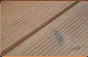
Verlegung ohne sichtbare Schrauben
